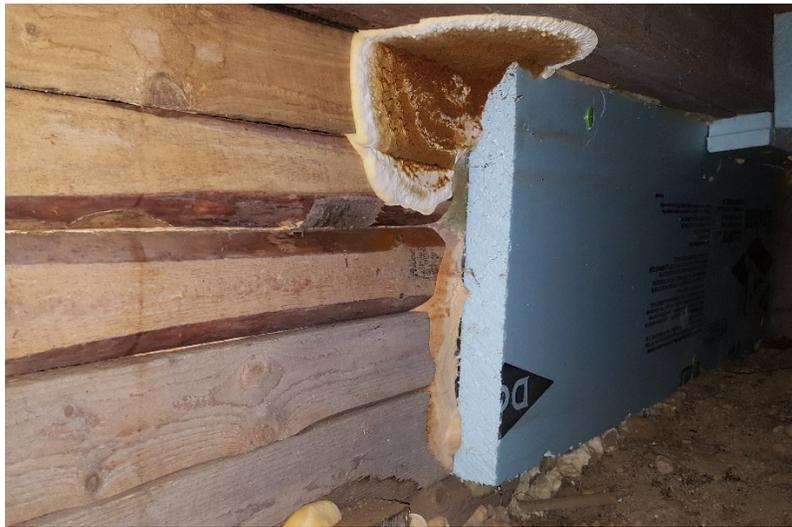
Figure 2.2 Appareil reproducteur de la mэрule pleureuse dans un vide sanitaire
