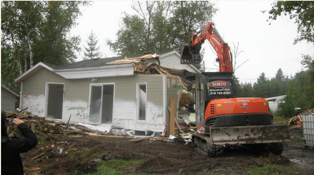
Figure 6 : Démolition d'une maison contaminée Source : SHQ
