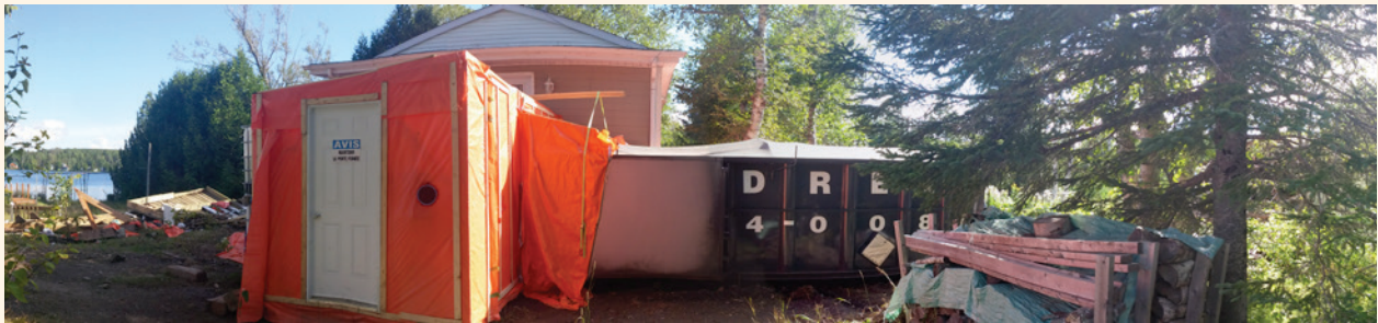
Figure 7 : Mesures de précaution Source : SHQ
